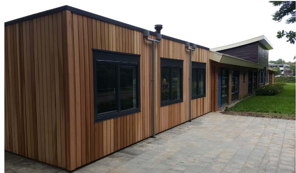
referentie tijdelijke schoolhuisvesting
