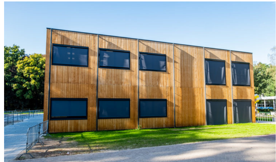
referentie tijdelijke schoolhuisvesting
