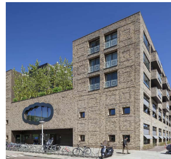
Dubbelgrondgebruik: Basisschool met erboven woningen en een daktuin
